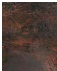
U193 FUS Underground Rouille
